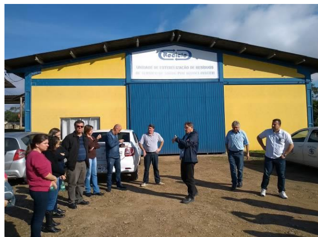
Figura 4. Vista frontal da unidade de autoclavagem dos resíduos de serviço de saúde
