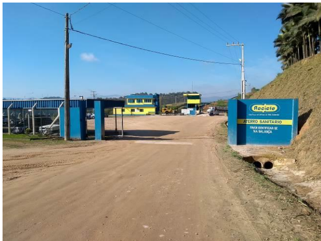
Figura 1. Portão de entrada da empresa Recicle Catarinense de Resíduos Ltda.
