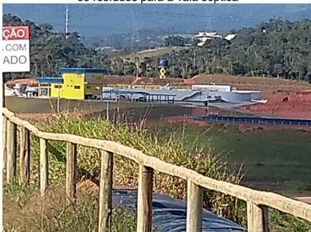
Figura 9. Unidade de tratamento de efluentes
