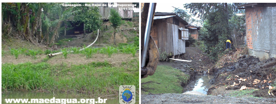
Exemplos de destino de esgoto a céu aberto/rio
