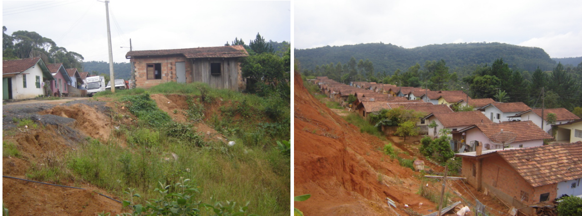
Exemplos de áreas sujeitas deslizamentos/desbarrancamentos
