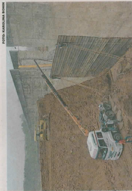
Construção do canal extravasor para a sobrelevação em dois metros da barragem Oeste, de Taíó
