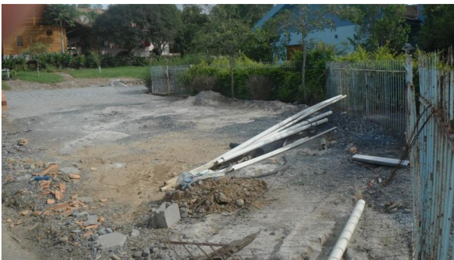
Restos de entulhos de construção – Janeiro 2013
