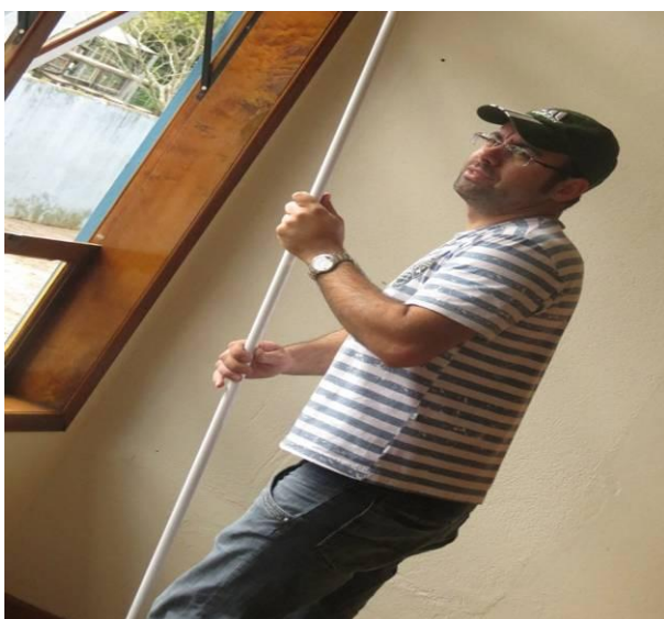
Colocando suporte das cortinas – Agosto 2013
