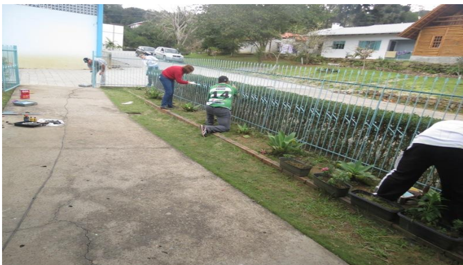
Solda e pintura – agosto 2013
