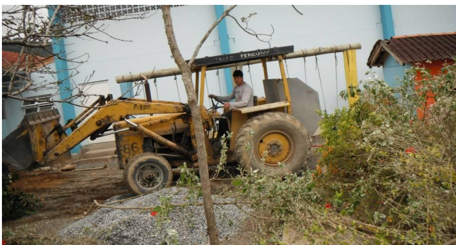
Retirando entulhos – Maio 2013
