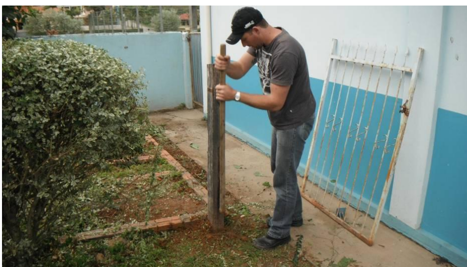
Recolocando portão - Maio 2013
