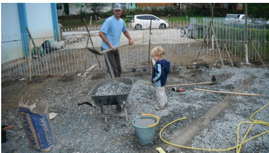
Aluno vistoriando a obra – Maio 2013
